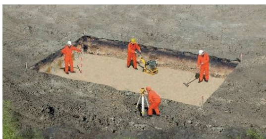
Obrázek 7: Příprava vyrovnaného základu
