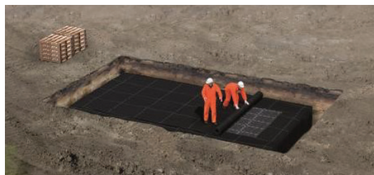
Obrázek 13: Zakrytí geotextilií
